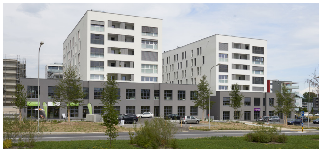
ROUTE DE SIGNY 35 - CHEMIN FALCONNIER 5-9 - NYON (VD):
