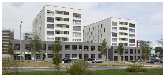
ROUTE DE SIGNY 35 - CHEMIN FALCONNIER 5-9 - NYON (VD):
